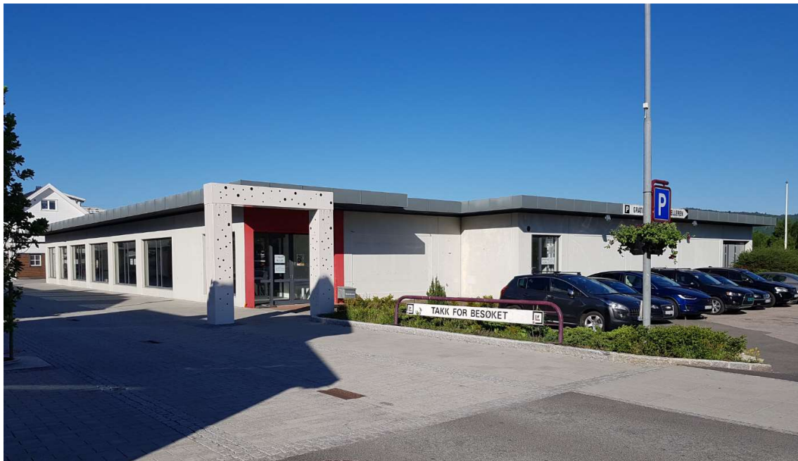
Figur 13. Foto fra Kirkeveien av eksisterende bebyggelse innenfor planområdet.
